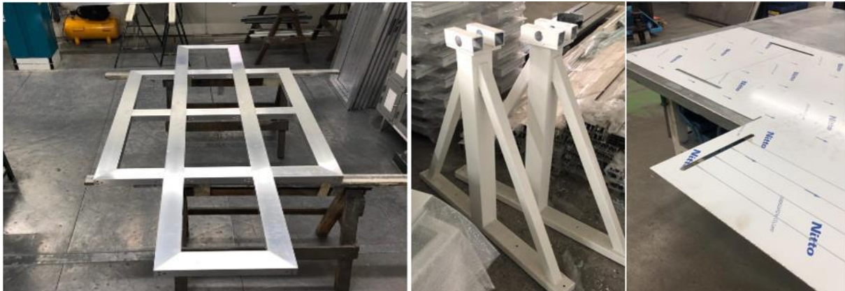
Figura 4 – Dispositivo em execução
