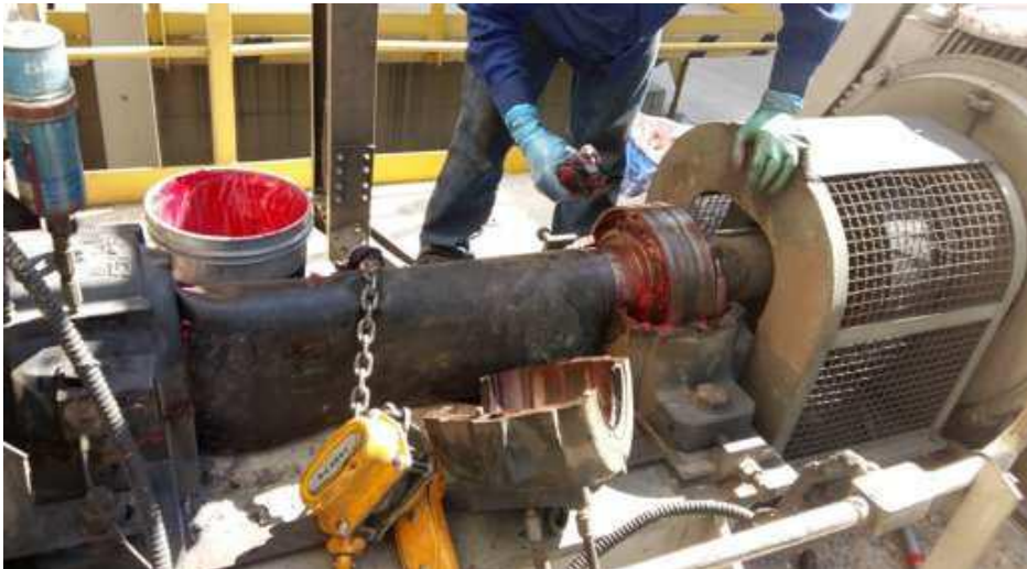
Figura 3: Execução da troca da graxa após aberto o mancal
