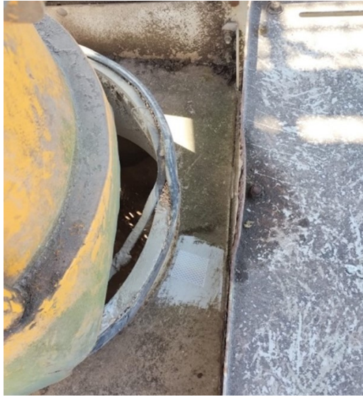
Figura 2 – Fitas refletivas instaladas nas gavetas da esteira.
