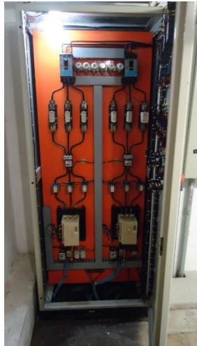
Figura 3 – Painel de partida dos CMBs
